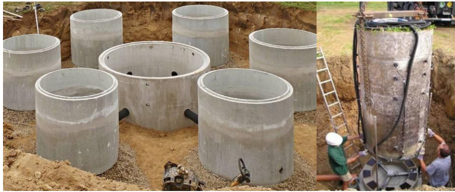
4.3. ábra. Liziméteres kísérlet telepítése (Fotó: Meter Group, Germany).
